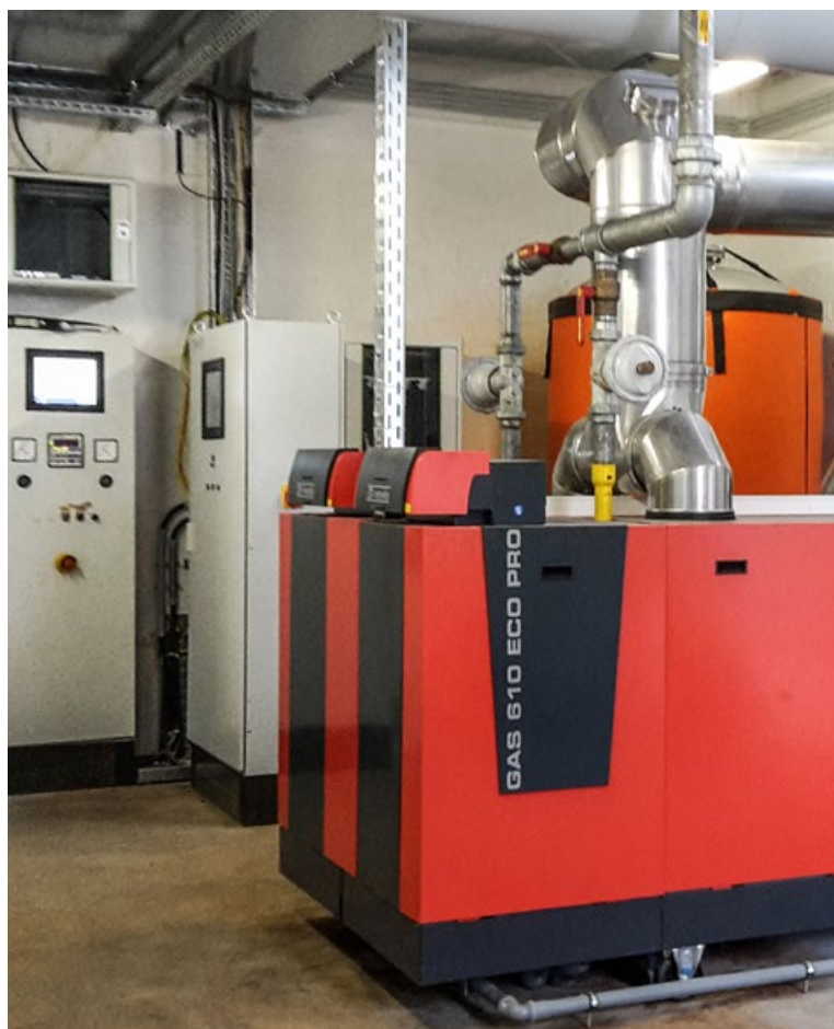
Spitzenlastkessel (links) und Wärmeverteiler (rechts)
