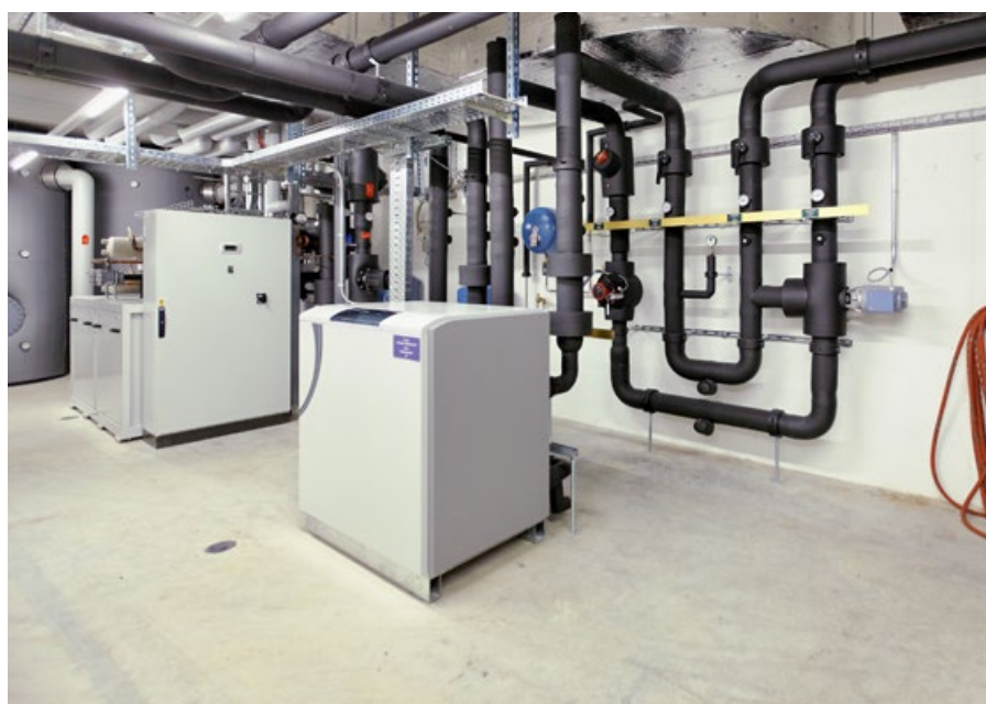
Pelletheizungsanlage
