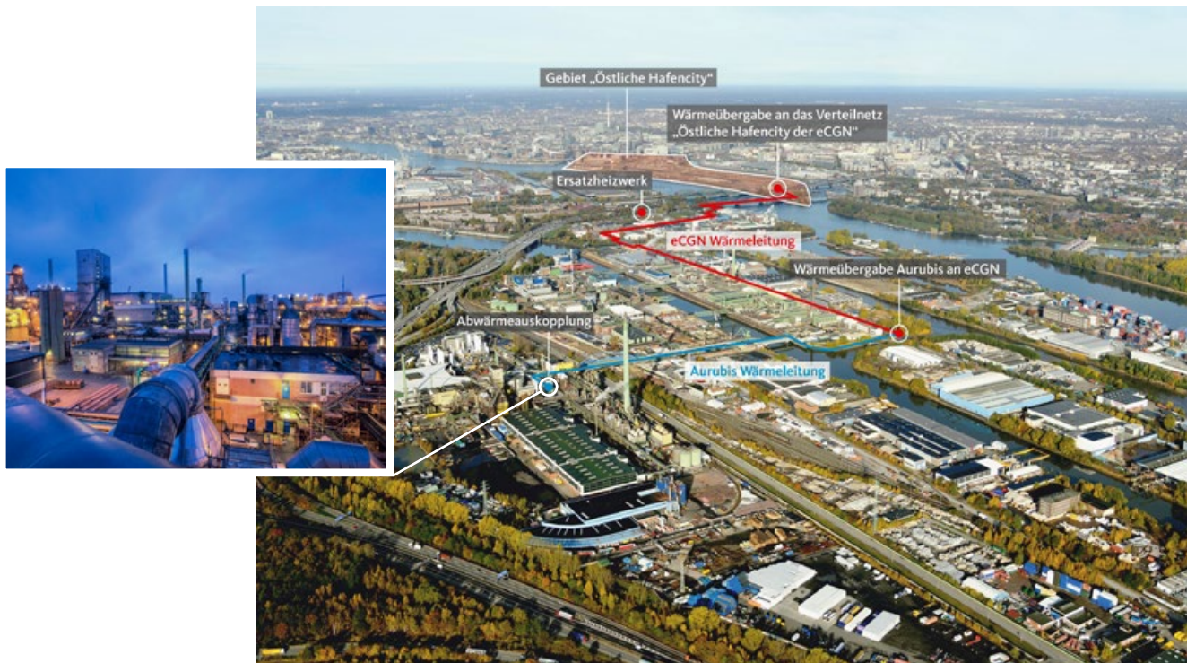
Kontaktanlage (links) Fernwärmetrasse (rechts)
