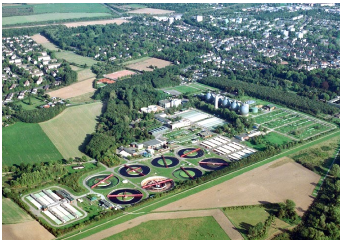
Großklärwerk (GKW) Köln-Stammheim und naheliegende Siedlung
